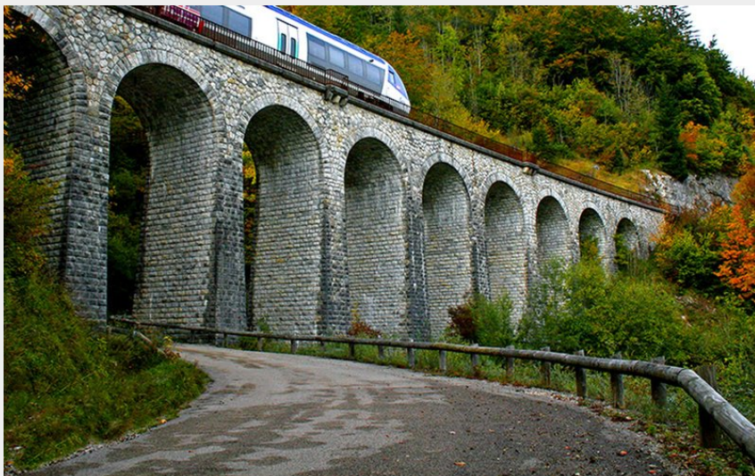
Crédit photo : LES VIADUCS DE MOREZ_4 (LES VIADUCS DE MOREZ)
