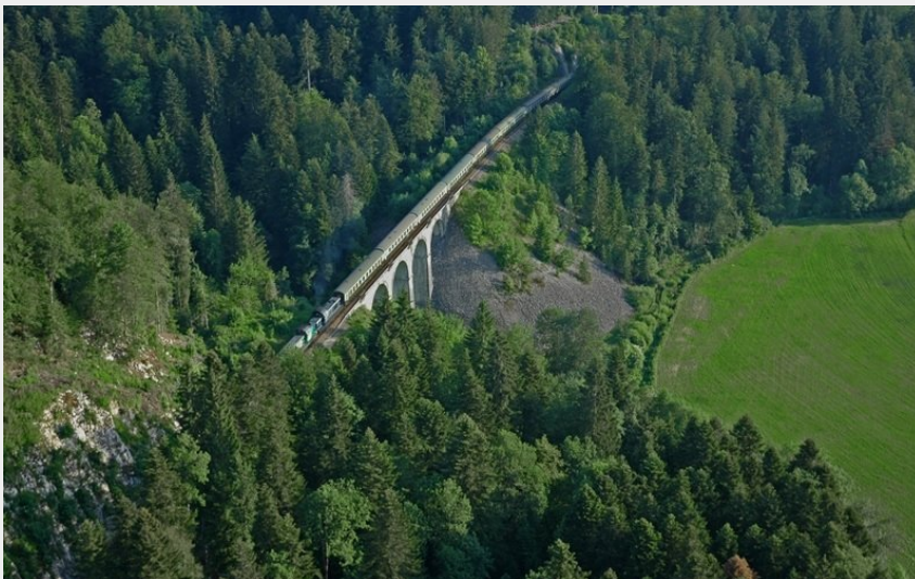
Crédit : Les Viaducs aux environs de Morez - JF Putod (©JF.Putod)
