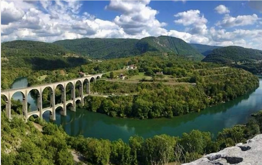
viaduc de Cize
