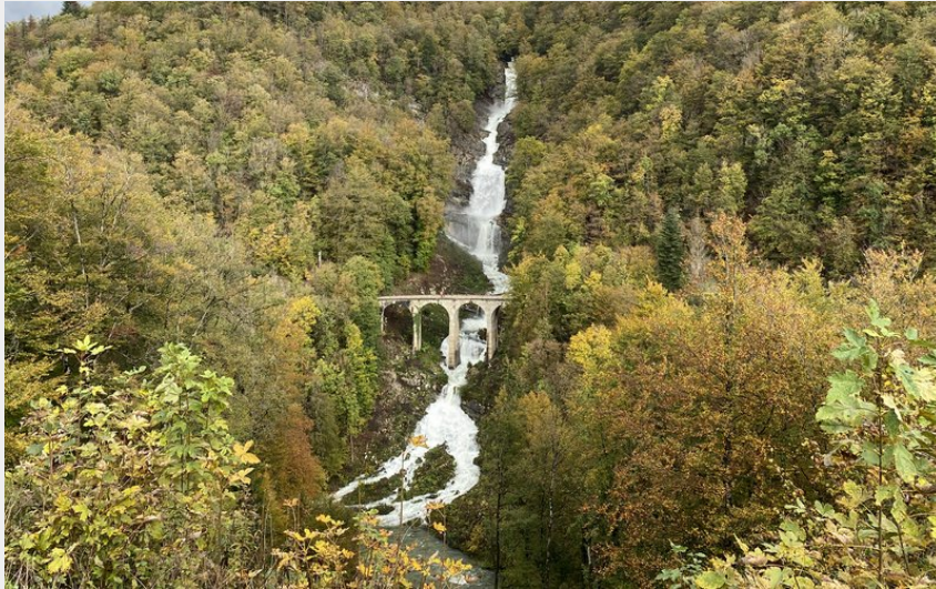
Vue de la cascade du Bief de la Ruine depuis le belvédère routier (© CC CNJ)
