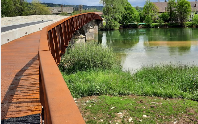
Pont de Pont du Navoy (© Jura Tourisme)
